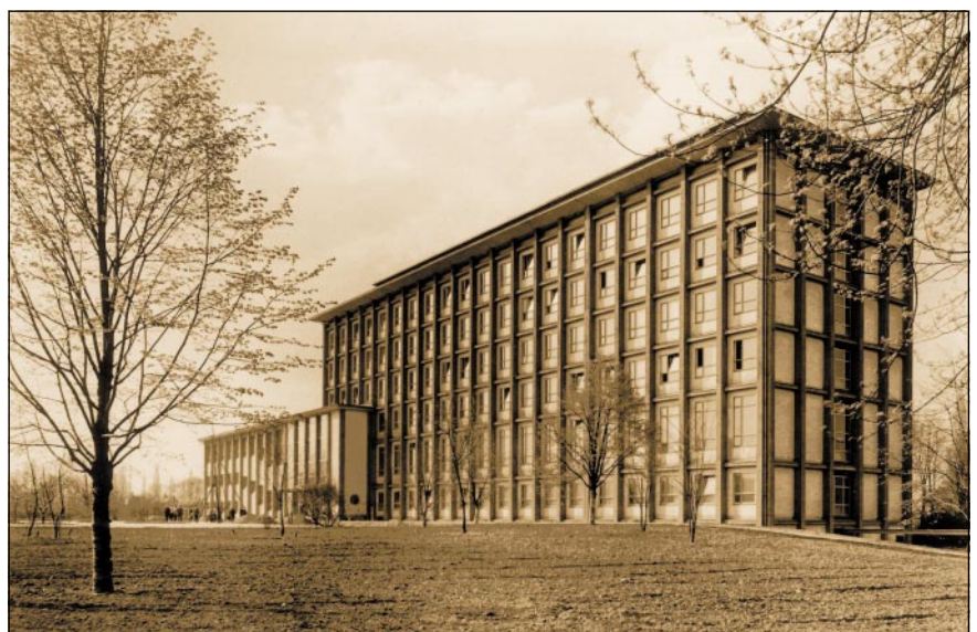
Bild 11: Andreas-Schubert-Bau, errichtet 1956 bis 1960
