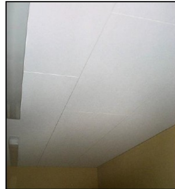
Abbildung 15: Vollflächig verlegte Mineralfaser-Deckenplatten
