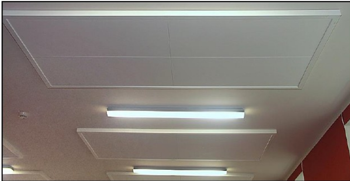
Abbildung 14: Mineralfaser-Deckenplatten in Direktmontage als berandete Teilflächen
