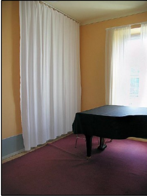
Abbildung 25: Molton-Vorhänge als Schallabsorberflächen in einem Überaum
