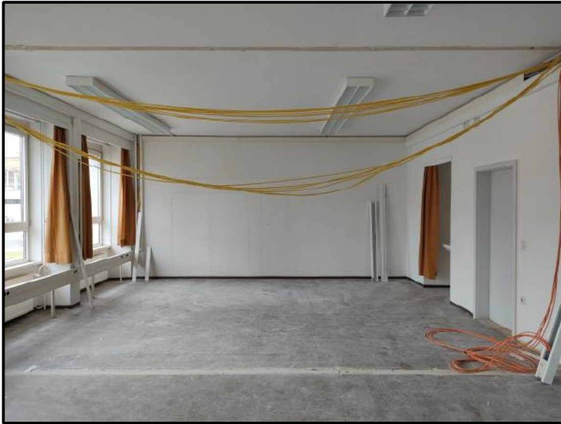
Abbildung 1: Seminarraum E017 im unfertigen Zustand zum Zeitpunkt der Messung
