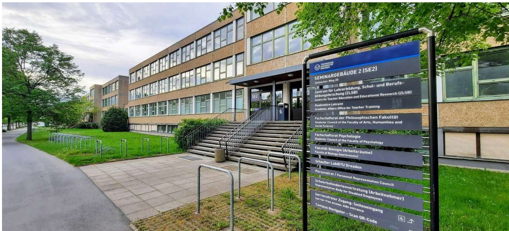
Urheber Studienbüro Lehramt
